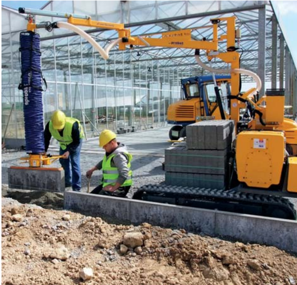
TRANSMOBIL TM Transporteur de pose pour la pose de bordures
