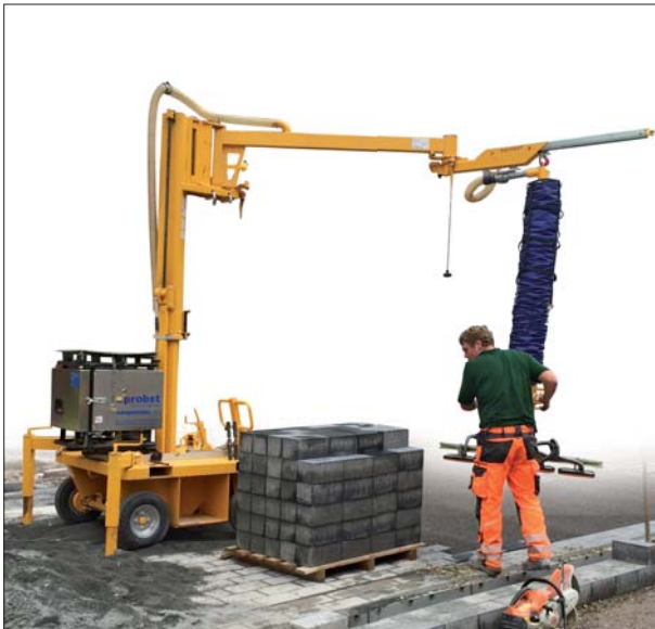
JUMBOMOBIL JM-VARIO Machine pose dalles par aspiration
