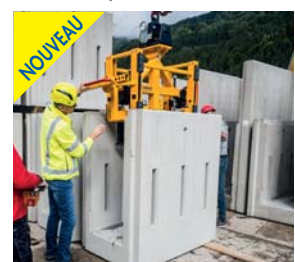
Pince mécanique pour pose d'éléments de murs de tranchée
