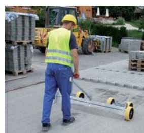
LEVELFIX LF-125/215 Système de nivellement manuel
