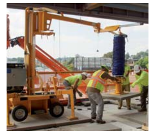
JUMBOMOBIL JM-VARIO Machine pose dalles par aspiration
