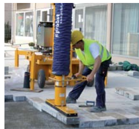
JUMBOMOBIL JM-VARIO Machine pose dalles par aspiration
