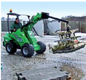
Pince hydraulique pour pavés combinée à une mini-pelle
